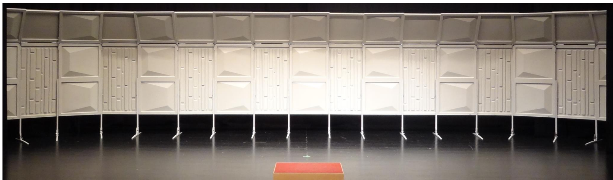
使用台数：正面反射板：ベースパネル9台 + フィラーパネル8台
